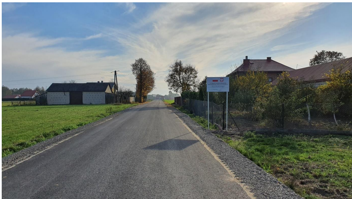
Foto: Droga gminna w Stoczku Kockim po przebudowie, źródło własne
