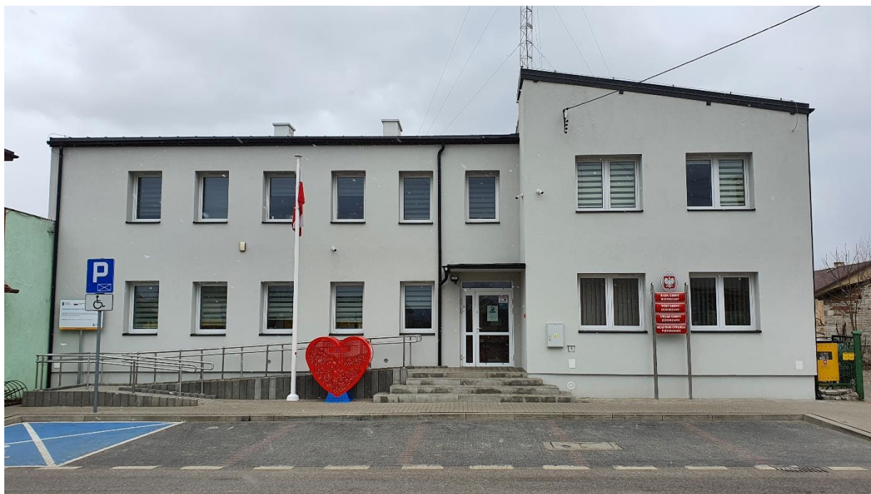
Foto: Budynek Urzędu Gminy Jeziorzany po termomodernizacji, źródło własne
