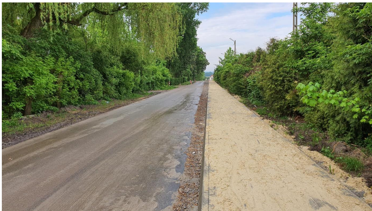
Foto: Droga gminna w Przytocznie w trakcie przebudowy, źródło własne
