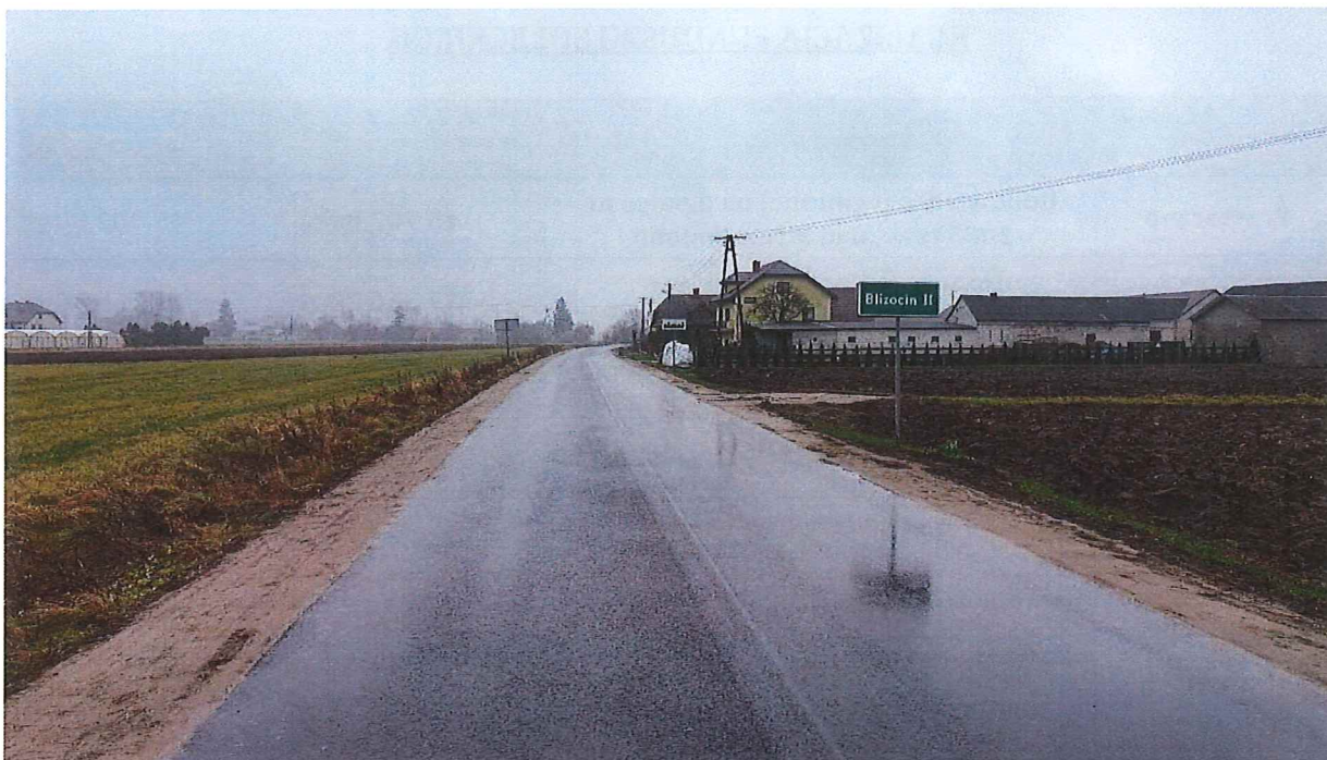
Foto 5: Droga powiatowa Jeziorzany - Sobieszyn po częściowym remoncie w miejscowości Blizocin, źródło własne.
