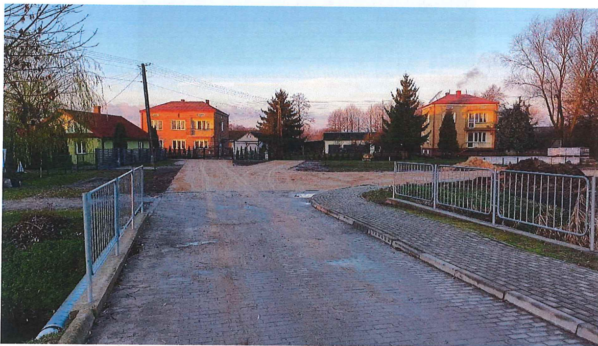
Foto 4: Droga gminna w Przytocznie w trakcie przebudowy, źródło własne.
